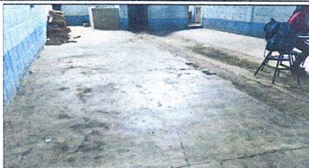
Foto 1: Sustrucción de piso de torta por piso cerámico en aulas y pasillos
