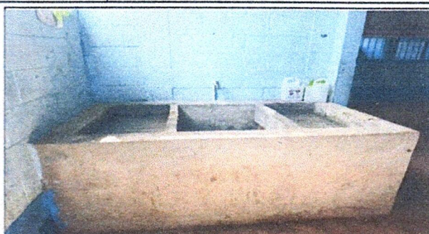
Foto 2: Suministro de azulejo para revestimiento de pila de concreto interior y exterior de 2.5x1.5 mt
