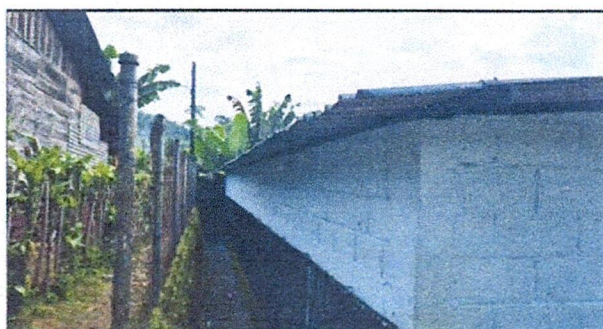
Foto 4: Suministro de canales de agua pluvial de metal más pescantes
