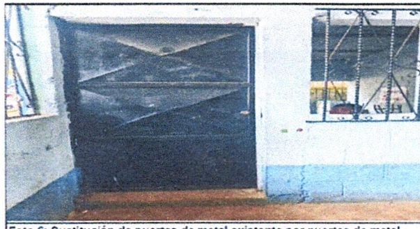
Foto 6: Sustrucción de puertas de metal existente por puertas de metal
