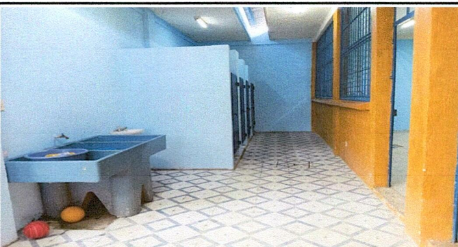
Foto 11: Referencia renglón 2.5 (sustitución de piso de torta de cemento x piso cerámico antideslizante)
