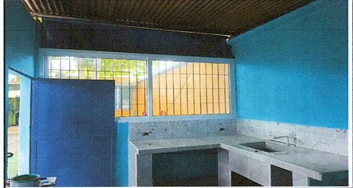
Foto 8: Referencia renglón 1.98 y 1.99 (pintura, limpieza y resanado de paredes + sustitución de piso de torta de cemento por piso cerámico)
