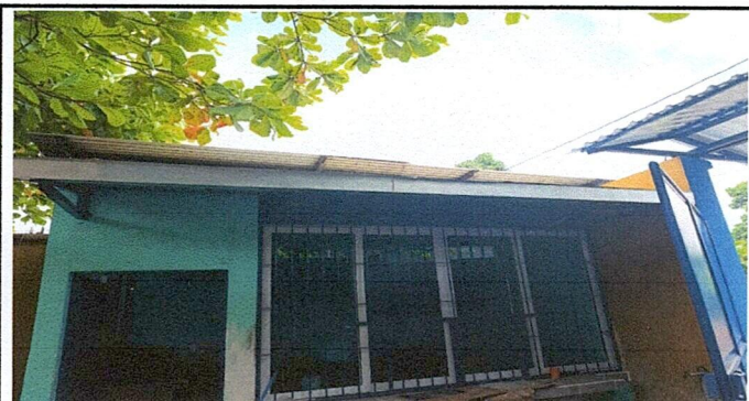
Foto 3: Referencia renglón 1.4, 1.5 y 1.9 (suministro de balcón de metal, ventana de pvc + estructura metálica para cubrir vano de ventana)
