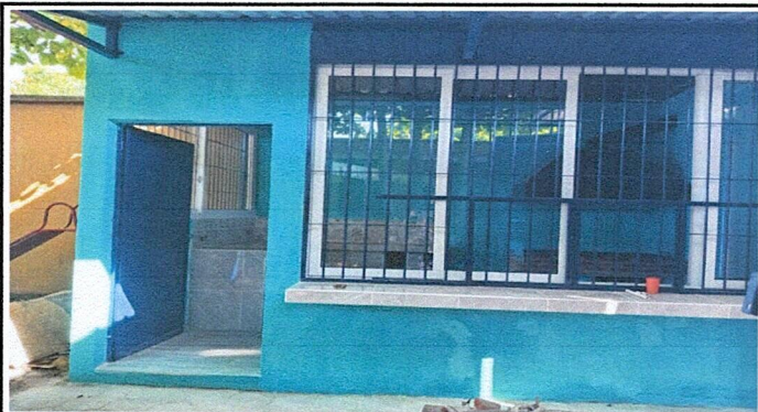
Foto 1: Referencia renglón 1.1 (reparación y mantenimiento de puerta de metal)
