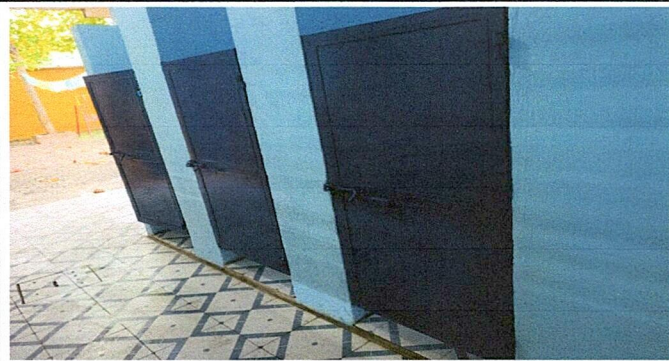
Foto 9: Referencia renglón 2.1 y 2.2 (Mantenimiento de puertas de metal + pintura, limpieza y resanado de paredes y cenefa, incluye mano de obra)
