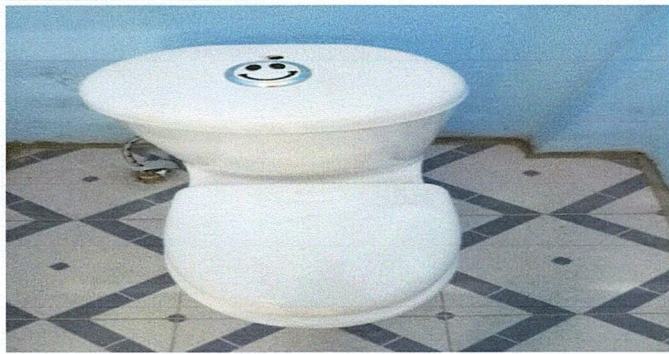
Foto 7: Referencia renglón 2.5 (sustitución de piso de torta de cemento por piso cerámico antideslizante)
