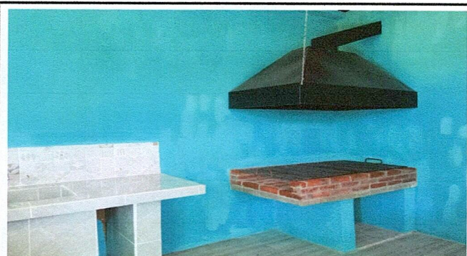
Foto 5: Referencia renglón 1.91 (suministro de gabinete plancha fundida de concreto en L con fosa de lavatrastos + azulejo)
