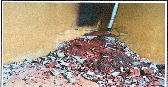
Foto 4: Referencia renglón 1.6, 1.7, 1.93, 1.94 (sustitución de chimenea de metal, remate lateral de lámina lisa calibre 26, sustitución de polletón y sustitución de plancha de metal x parrilla)
