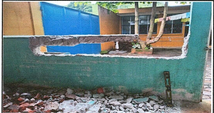
Foto 2: Referencia renglón 1.2, 1.3, 1.8 (suministro de balcón de metal, ventana PVC, + estructura metálica para cubrir vano de ventana)
