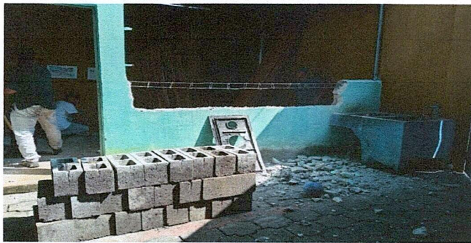
Foto 1: Referencia renglón 1.1 (reparación y mantenimiento de puerta de metal)
