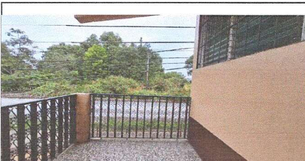
FOTO 6: Cerramiento de muro en fachada frontal de módulo de aulas en segundo nivel
