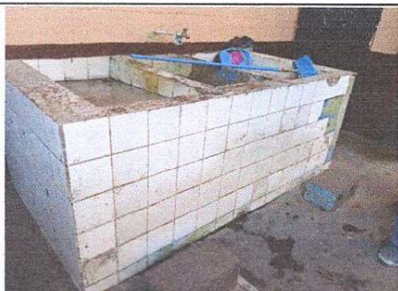
FOTO 5: Sustitución de pileta + colocación de azulejo
