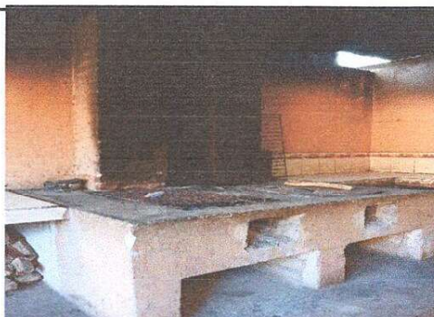
FOTO 3: Sustitución de estufa Rural + chimenea
