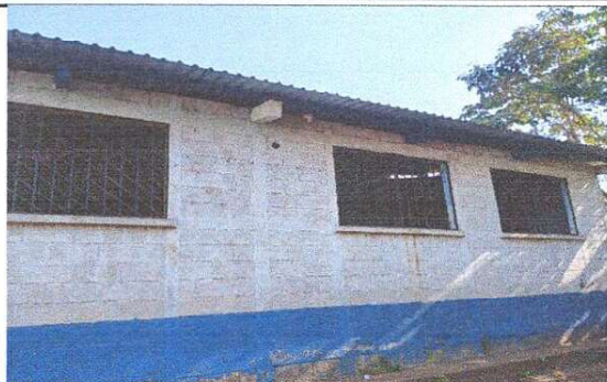
FOTO 1: Suministro de ventanas + balcones de metal en paredes exteriores de módulo de aulas
