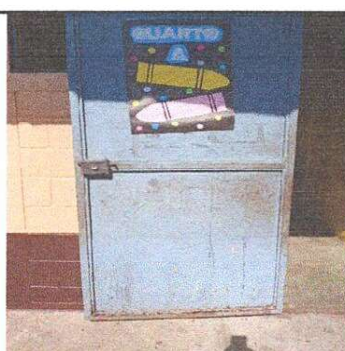
FOTO 4: Mantenimiento de puertas de metal
