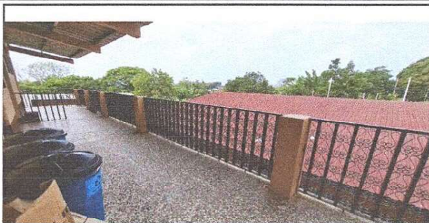
FOTO 2: Refuerzo de barandal en área de pasillo de módulo de aulas en segundo nivel
