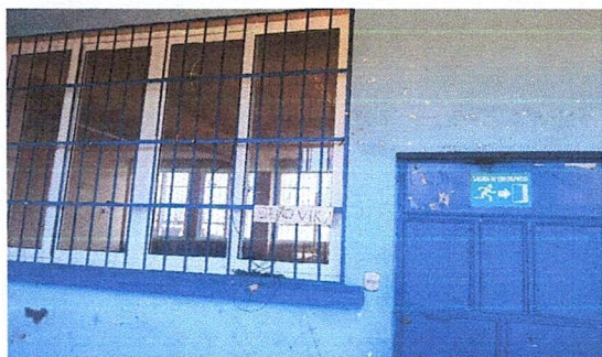
Fabricacion e instalación de ventanas PVC corredizas de atrás y adelante ( aula 1)
