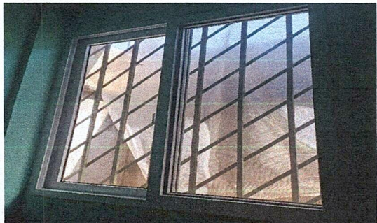
Fabricación e instalación de ventanas PVC corredizas de atrás y adelante (Dirección)
