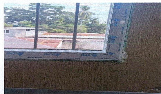
Fabricacion e instalación de ventanas PVC corredizas de atrás y adelante (aula 5)
