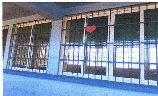
Fabricacion e instalación de ventanas PVC corredizas de atrás y adelante (aula 2)
