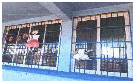
Fabricacion e instalación de ventanas PVC corredizas de atrás y adelante (aula 4)
