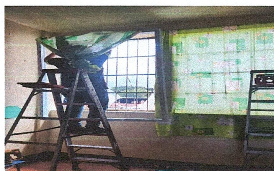
Fabricacion e instalación de ventanas PVC corredizas de atrás y adelante (aula 2)
