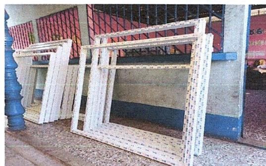
Fabricacion e instalación de ventanas PVC corredizas de atrás y adelante (aula 4)
