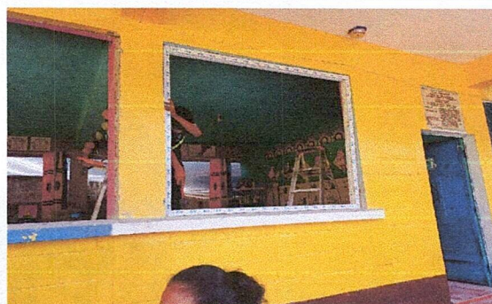
Fabricacion e instalación de ventanas PVC corredizas de atrás y adelante ( aula 3)
