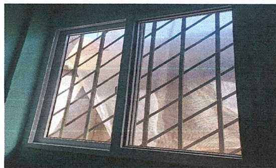
Fabricacion e instalación de ventanas PVC corredizas de atrás y adelante (aula 6)
