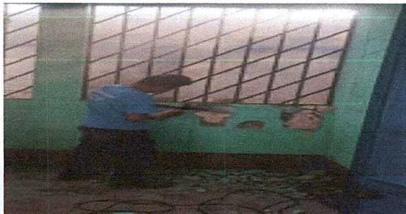
Fabricación e instalación de ventanas PVC corredizas de atrás y adelante (Dirección)
