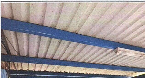
FOTO 4: Reparación de cubierta de lámina
