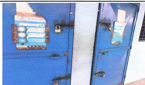
FOTO 3: Mantenimiento de puertas de módulo de servicios sanitarios
