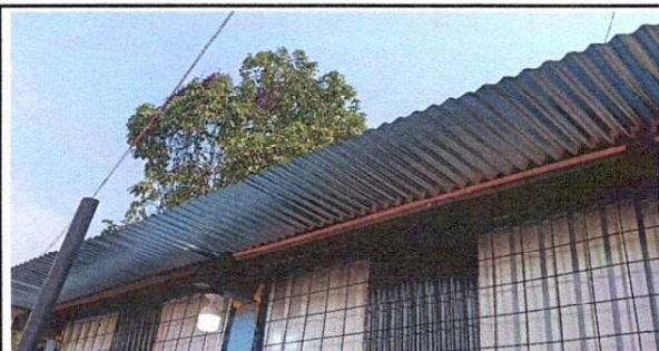
FOTO 5: Suministro de canal de metal para módulo de cocina
