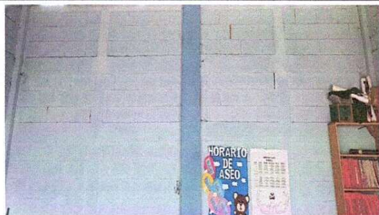
FOTO 1: Apertura de ventanas, suministro de ventana y balcones
