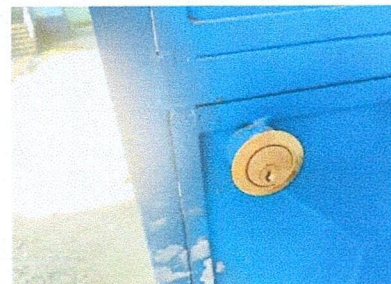
Foto 6: suministro e instalacion de puerta 1.00 x 1.20 de metal en cocina
