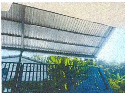
Foto 1: Cubierta de lamina estructura de techo
