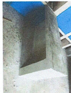
Foto 4: Pintura en muros exteriores
