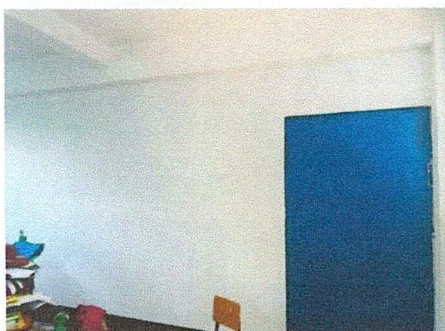
Foto 3: suministro e instalacion de marco de metal divisor de aulas con chapa area de computación
