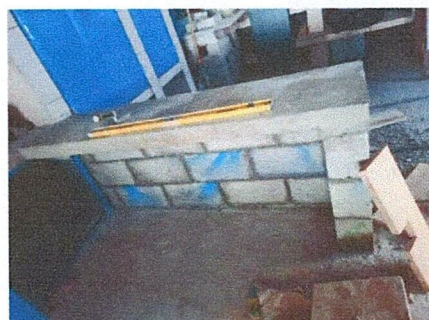
Foto 4: Pintura en muros exteriores
