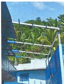
Foto 1: Cubierta de lamina estructura de techo
