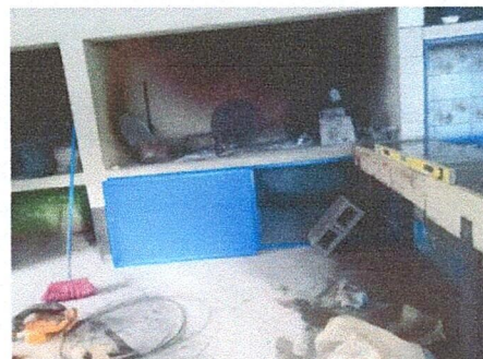
Foto 2: suministro e instalacion de puerta dos hojas 2.09 x 0.68 de metal
