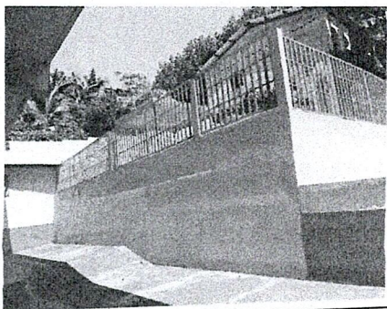
Foto 1: Pintura en muros exteriores
