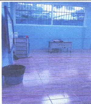
Foto 5: Sustitución de piso de granito por piso cerámico.
