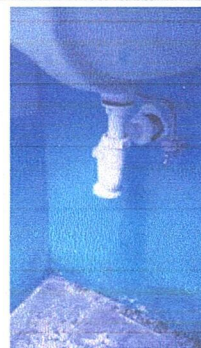
Foto 8: Sustitución de mezcladora lavamanos(contra llave, tubo de abasto)
