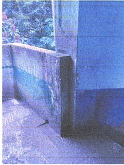
Foto 1: Impermeabilización de losa
