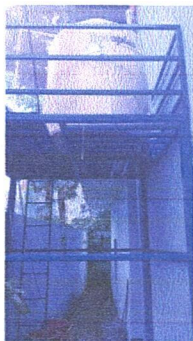
Foto 2.5: Suministro de estructura portante de metal para tanque elevado de 2.00x2.00x3.90
