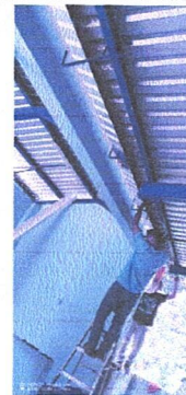
Foto 2.2: Suministro de Canal de metal en módulo de aulas
