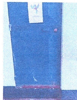
Foto 2: Mantenimiento a estructuras (lijado, cepillado, sufecciones, aplicación de dos manos puertas aulas)
