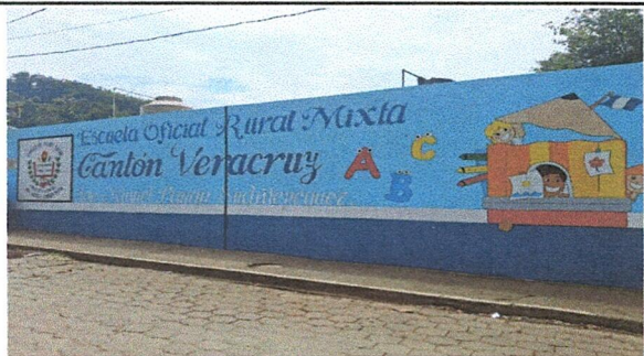
Foto 1: Pintura en muros exteriores e interiores de aulas.
