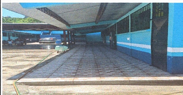
Foto 5: sustitución de torta de concreto.
