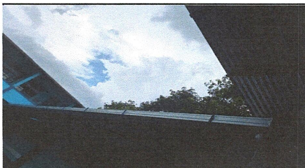
Foto 4: Sustitución de canal de metal
