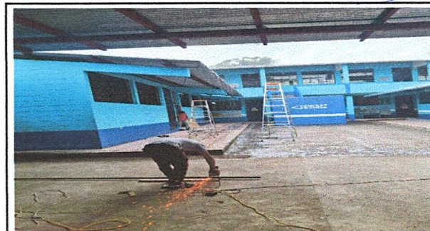
Foto 4: Sustitución de canal de metal
