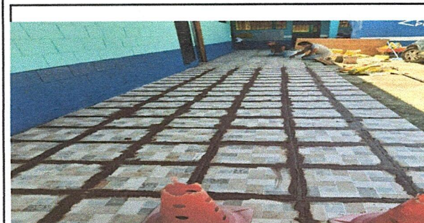
Foto 5: sustitución de torta de concreto.
