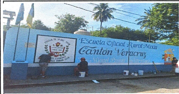
Foto 1: Pintura en muros exteriores e interiores de aulas.
