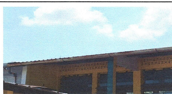
Foto 4: Sustrucción de canal de metal
