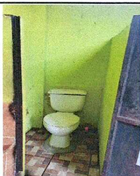
Foto 5: Sustitución de hinodoros
