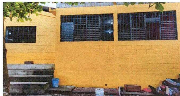
Foto 2: Sustitución de ventanas de paletas a Pvc
