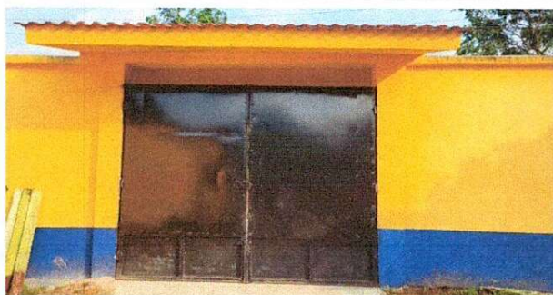
Foto 3: Mantenimiento de portón de metal central
