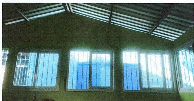
Foto1: suministro e instalación de ventana
