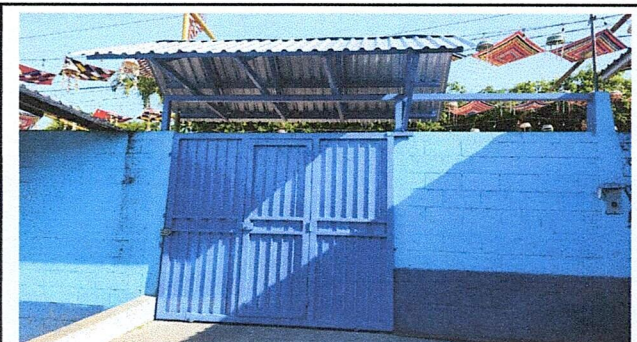
Foto 6: sustitución e instalación de portón
