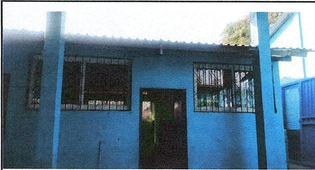
Foto 3: Sustitución de balcón e instalación de ventana
