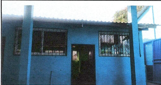
Foto 3: Sustitución de balcón e instalación de ventana
