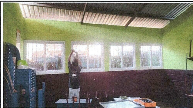
Foto 4: Sustitución de balcón y suministro e instalación de ventana
