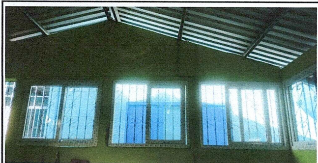
Foto 5: suministro e instalación de ventanas y balcón
