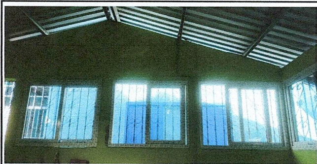
Foto 5: suministro e instalación de ventanas y balcón
