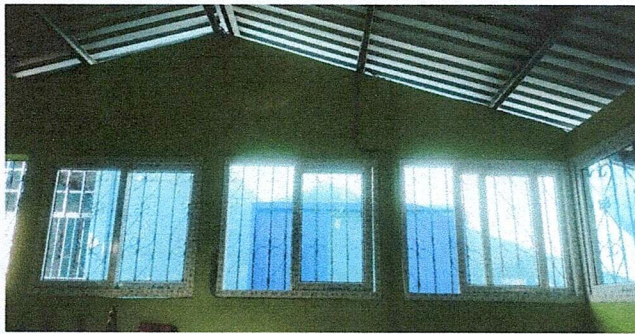
Foto1: suministro e instalación de ventana
