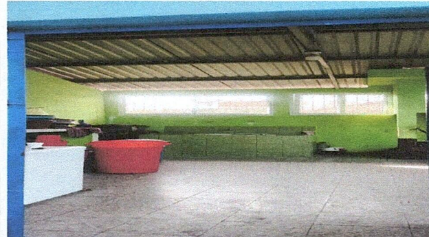
Foto 2: suministro e instalación de ventana
