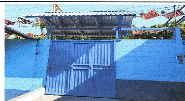
Foto 6: sustitución e instalación de portón
