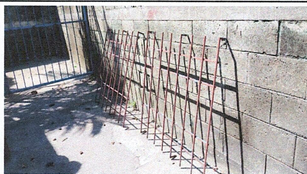
Foto 4: Sustitución de balcón y suministro e instalación de ventana
