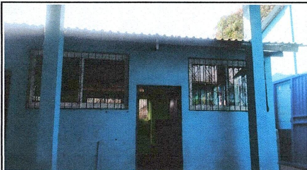
Foto1: suministro e instalación de ventana
