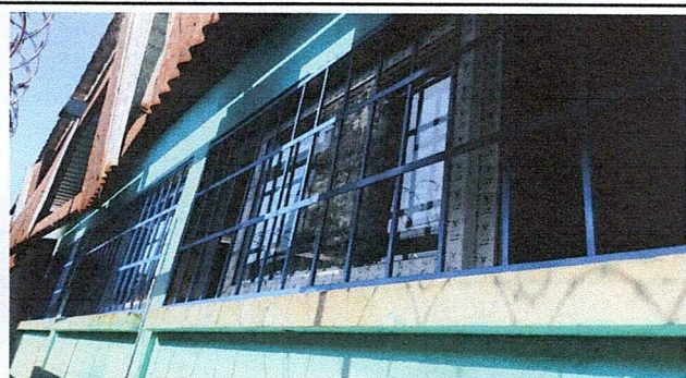
Foto 5: suministro e instalación de ventanas y balcón
