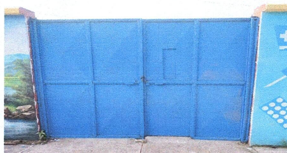
Foto 6: sustitución e instalación de portón
