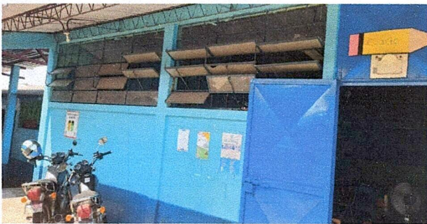
Foto 5: suministro e instalación de ventanas y balcón
