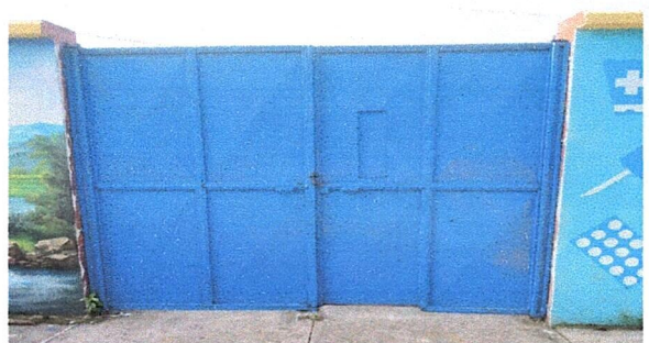
Foto 6: sustitución e instalación de portón
