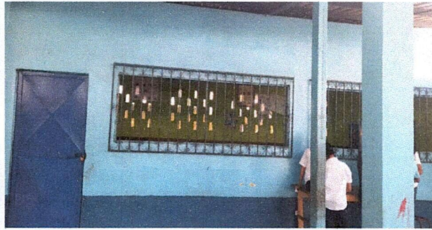
Foto 3: Sustitución de balcón e instalación de ventana
