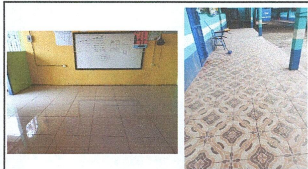
Foto 6: Sustitución de piso por piso cerámico
