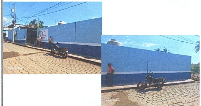
Foto 10: Pintura en paredes exteriores
