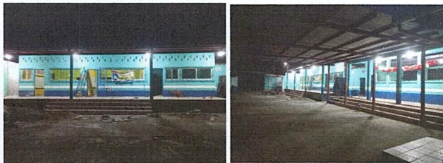
Foto 9: Reparación del sistema eléctrico
