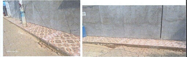
Foto 8: Reparacion de banqueta y colocación de piso cerámico
