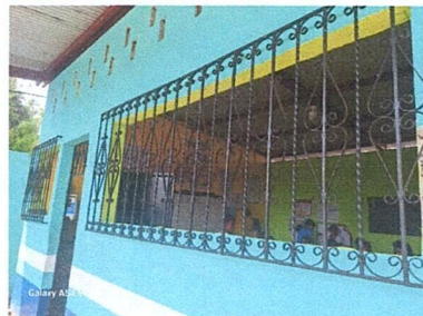
Foto 2: Suministro e instalación de ventana U-PVC vidrio 5mm
