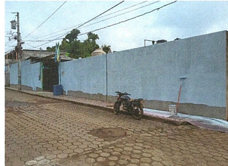
Foto 10: Pintura en exteriores
