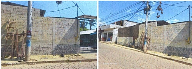
Foto7: Repello y cernido de paredes exteriores
