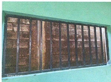
Foto 1: Suministro e instalación de balcón metálico con marco de angular 1" x 1" x 1/8" reforzado con hierro 1/2"
