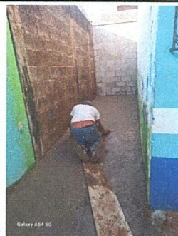
Foto 4: Suministro de concreto t:0.10
