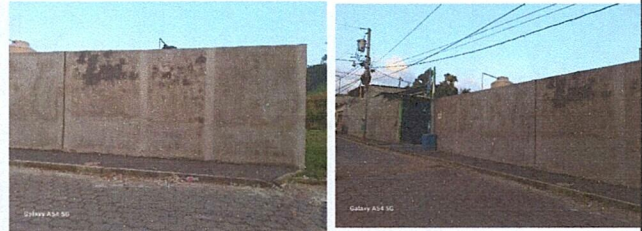
Foto 8: Reparacion de banqueta
