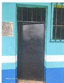
Foto 3: Sustitución de puerta de metal por puerta de metal 0.88 x 2.33, Suministro e instalación de contrapuerta de metal 0.88 x 2.33
