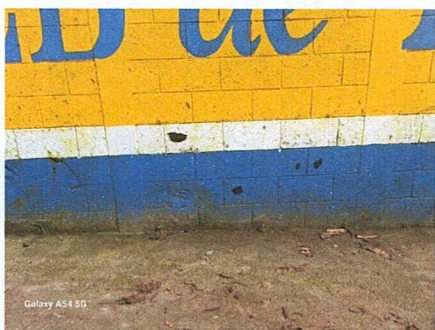
Foto 7: Repello y cernido de paredes exteriores
