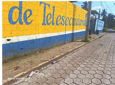
Foto 8: Reparacion de banqueta
