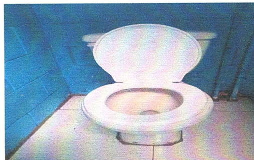
Foto 2: Sustitución de accesorios de sanitarios y sustitución de piso cerámico
