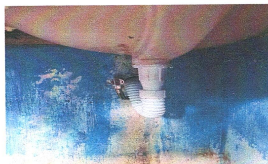
Foto 4: Sustitución de accesorios de Lavamanos
