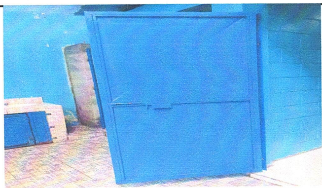
Foto 3: Sustitución de puertas de baño
