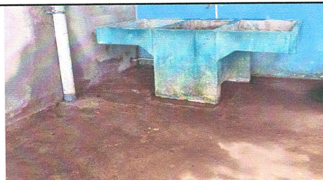
Foto 6: Reparación de red de drenaje de pila, Sustitución de tubería .
