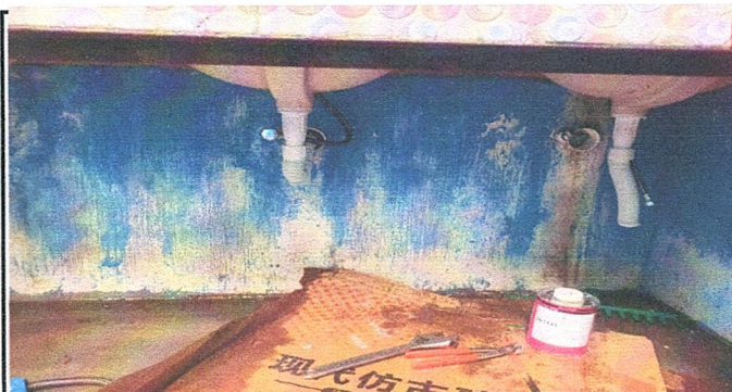
Foto 4: Sustitución de accesorios de Lavamanos
