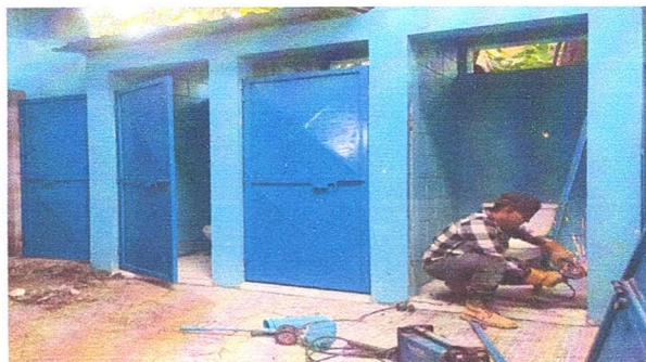
Foto 3: Sustitución de puertas de baño
