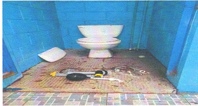
Foto 2: Sustitución de accesorios de sanitarios y sustitución de piso cerámico
