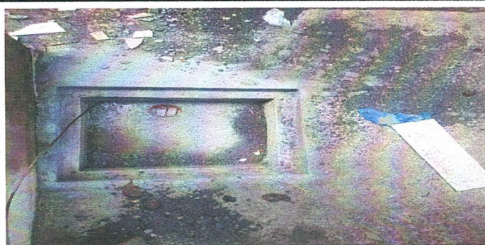
Foto 5: Elaboración de nuevas reposaderas
