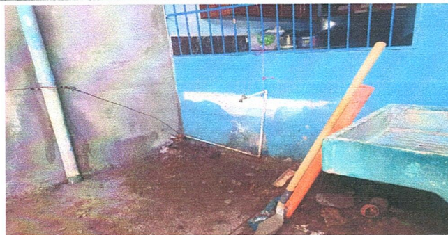
Foto 6: Reparación de red de drenaje de pila, Sustitución de tubería .
