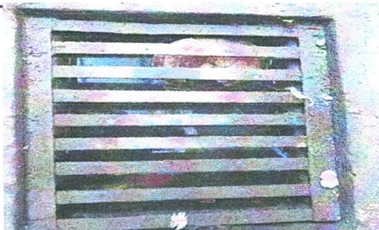
Foto 5: Mantenimiento a reposaderas
