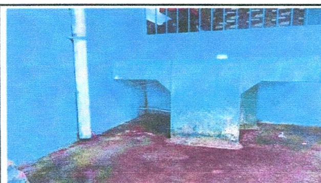
Foto 6: Reparación de red de drenaje de pila, Sustitución de tubería .
