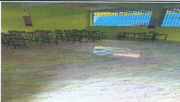
Foto 5: Sustitución de piso de cemento líquido por piso cerámico en aulas
