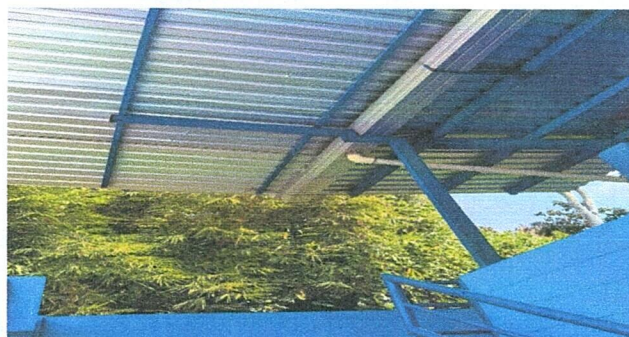
Foto 4: Extensión de estructura de techo de metal y cubierta de lámina
