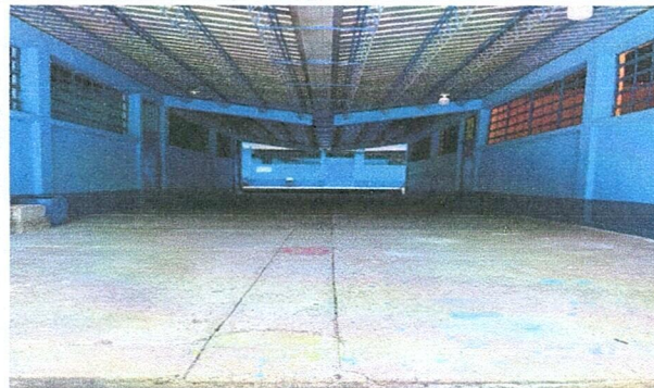
Foto 2: Mantenimiento, limpieza de canales y reparación de caja de agua pluvial
