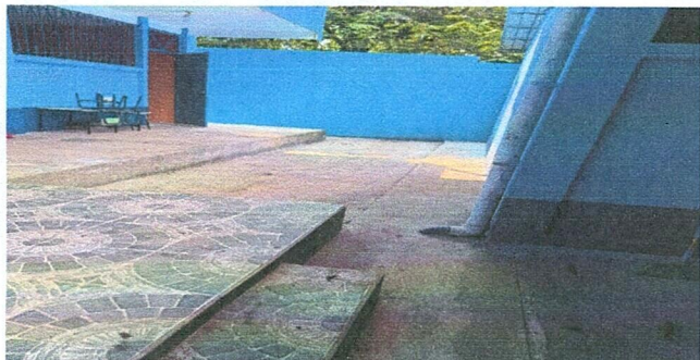
Foto 1: bajadas de agua pluvial tubo PVC 3"
