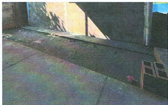
Foto 1: bajadas de agua pluvial tubo PVC 3"
