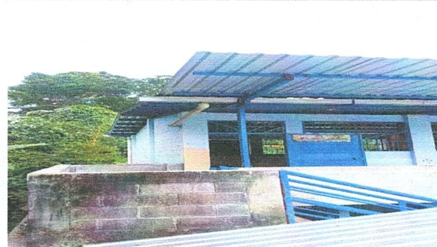
Foto 4: Extensión de estructura de techo de metal y cubierta de lámina
