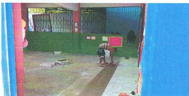
Foto 5: Sustitución de piso de cemento líquido por piso cerámico en aulas
