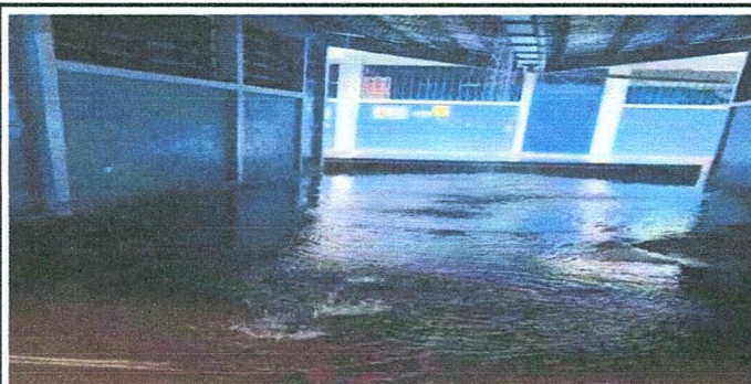
Foto 2: Mantenimiento, limpieza de canales y reparación de caja de agua pluvial
