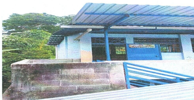
Foto 4: Extensión de estructura de techo de metal y cubierta de lámina
