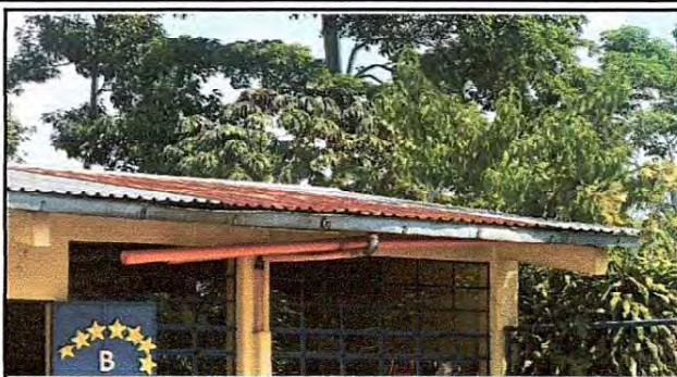
Foto 13: Sustitución de bajada de agua pluvial de metal por tubo PVC 3" (módulo 2)
