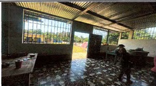
Foto 2: Suministro de mesa de trabajo de concreto y Azulejo
