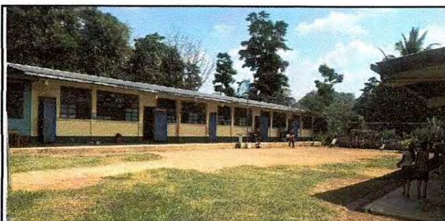
Foto 14: pintura en muros exteriores e interiores en aulas (módulo 2)
