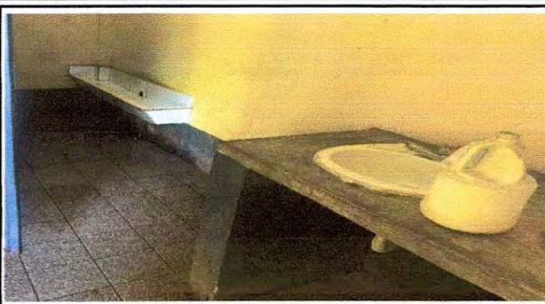
Foto 8: Demolición y suministro de lavamanos por Mingitorio (módulo 1)
