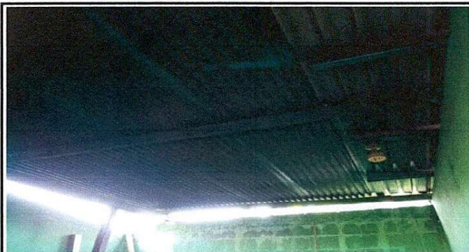
Foto 1: Sustitución de cubierta de lámina y estructura de soporte de metal, reparación de sistema eléctrico.
