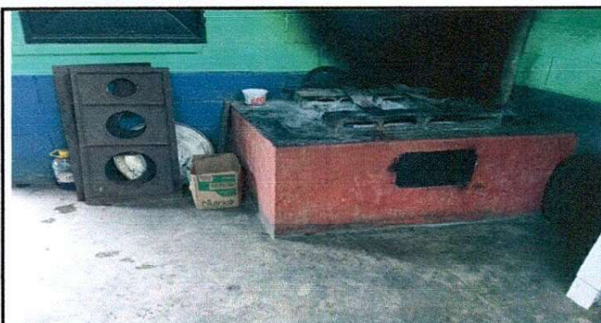
Foto 3: Sustitución de polletón y sustitución de piso
