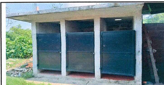
Foto 5: Mantenimiento de puertas en servicios sanitarios y suministro de azulejo
