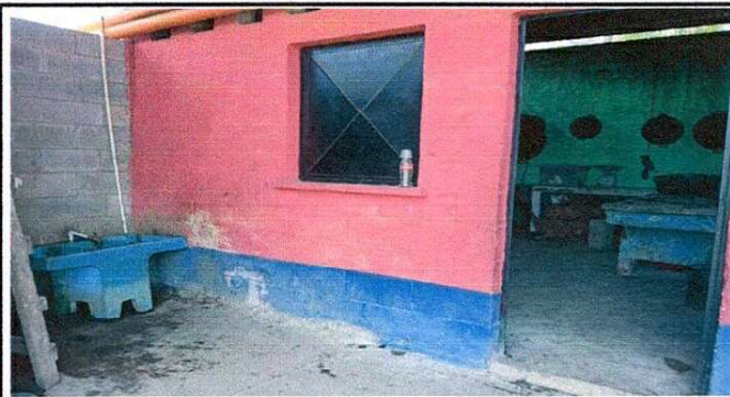
Foto 2: Sustitución de ventana existente por ventana de metal de 2 x 1 metro y suministro de balcón de metal.
