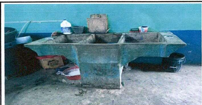
Foto 6: Sustitución de pila de concreto de 2 lavaderos.
