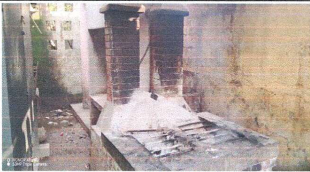
Foto 1: Reparación de área de cocina
