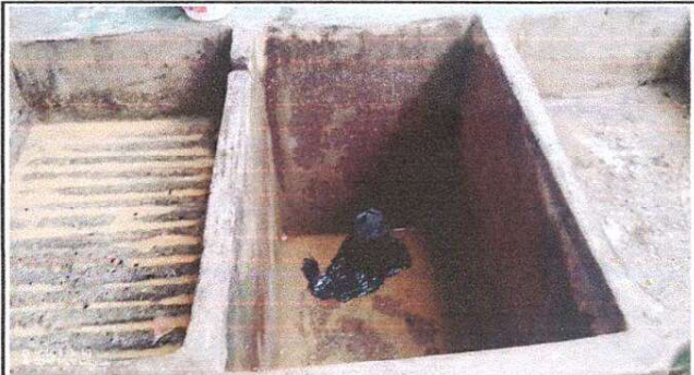
Foto 4: Sustitución de pila de cocina
