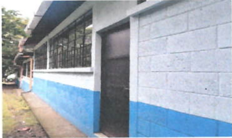
Foto 8: Referencia renglón 3.1 (mantenimiento a puerta de metal, en bodega).
