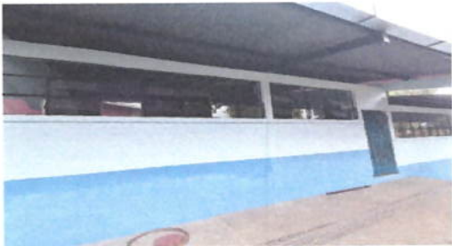
Foto 9: Referencia renglón 4.1 (mantenimiento a puertas de metal, en baños)
