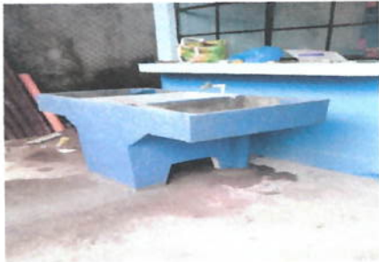
Foto 10: Referencia renglón 5.1 (sustitución de pila de 2 fregaderos).
