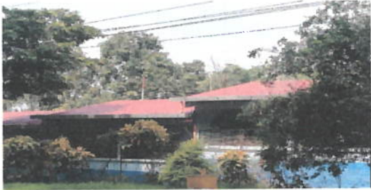
Foto 7: Referencia renglón 2.7 (mantenimiento a lamina, limpieza y aplicación de pintura anticorrosiva)
