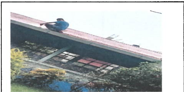
Foto 7: Referencia renglón 2.7 (mantenimiento a lamina, limpieza y aplicación de pintura anticorrosiva)
