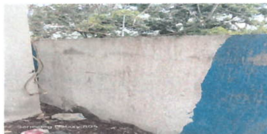
Foto 12: vista de la fachada principal de la escuela a intervenir.
