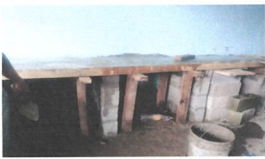
Foto 2: Referencia renglón 1.2 (suministro de gabinete de concreto con sus respectivas divisiones, debidamente azulejado).
