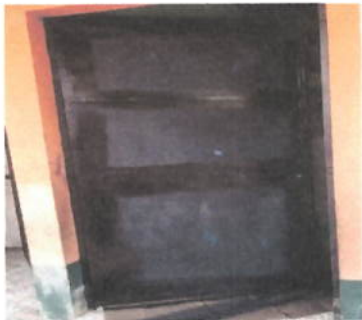
Foto 3: Referencia renglón 1.3 ( mantenimiento a puerta de cocina).
