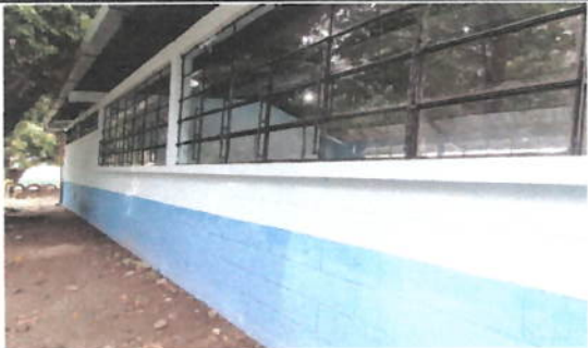
Foto 5: Referencia renglón 2.2 y 2.3 ( mantenimiento a ventana tipo balancín, y pintura de muros interiores y exteriores).
