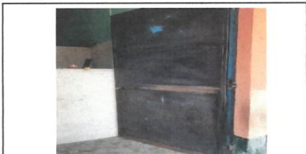
Foto 9: Referencia renglón 4.1 (mantenimiento a puertas de metal, en baños)
