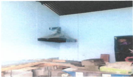
Foto 1: Referencia renglón 1.1 (sustitución de chimenea con plancha metálica y plancha de concreto estufa rural).
