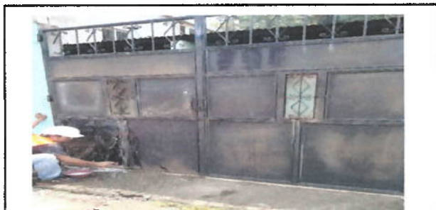
Foto 11: Referencia renglón 5.2 (mantenimiento a portón de metal)
