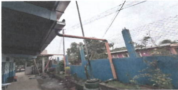
Foto 6: Referencia renglones 2.4, 2.5 y 2.6 (mantenimiento a estructura metálica soporte de techo, suministro de canal + bajadas de agua pluvial, y sustitución de lampara tipo candela).
