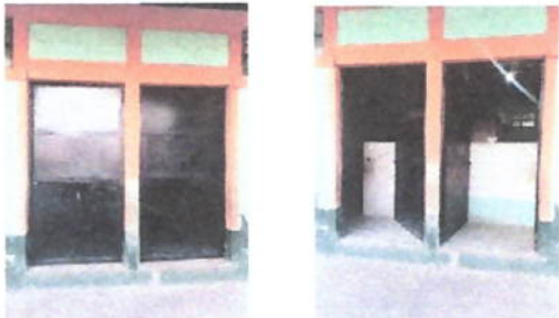
Foto 9: Referencia renglón 4.1 (mantenimiento a puertas de metal, en baños)
