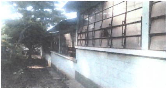
Foto 5: Referencia renglón 2.2 y 2.3 (mantenimiento a ventana tipo balcón, y pintura de muros interiores y exteriores).
