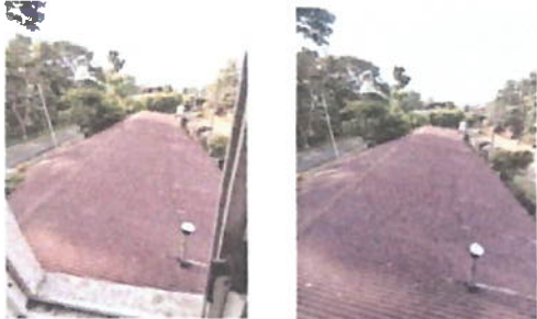
Foto 7: Referencia renglón 2.7 (mantenimiento a lamina, limpieza y aplicación de pintura anticorrosiva)
