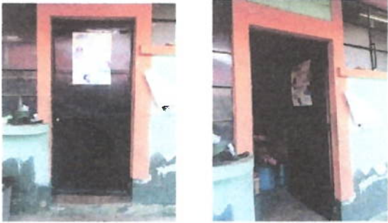
Foto 3: Referencia renglón 1.3 (mantenimiento a puerta de cocina).
