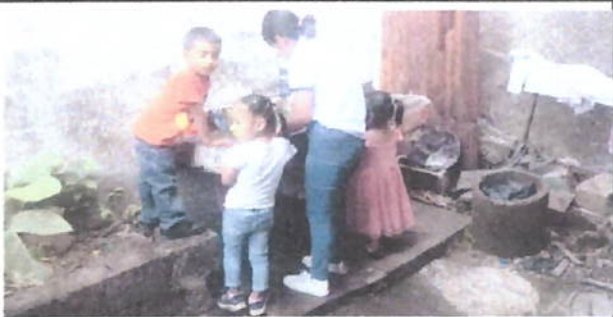
Foto 10: Referencia renglón 5.1 (sustitución de pila de 2 fregaderos).
