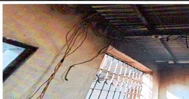
Foto 8: Sustrucción de cableado eléctrico incluye ducto y accesorio
