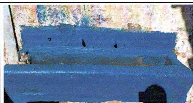
Foto 11: Sustrucción de 4 chorros
