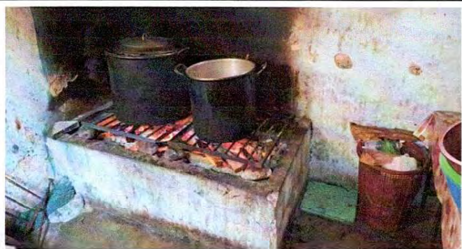
Foto1: Sustrucción de estufa rural (completa) incluye chimenea y plancha de metal
