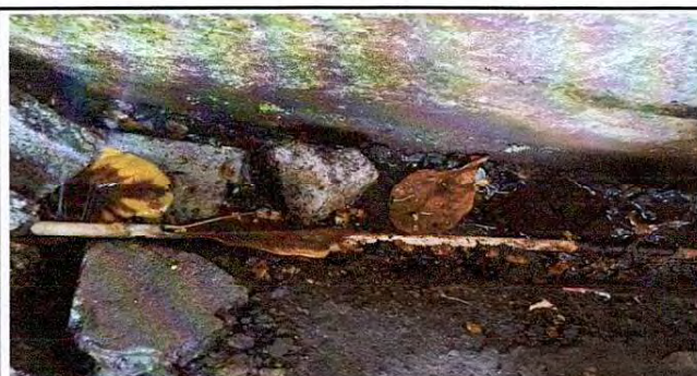
Foto 12: Reparación de tubería PVC en línea principal de agua potable
