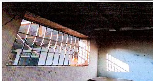
Foto 2: Instalación de balcones de metal en cocina
