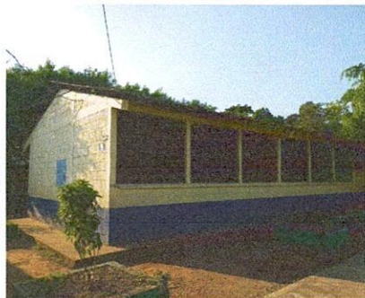
Foto 1: Sustrucción de lámina ondulado por lámina troquelada esmaltada calibre 26.
