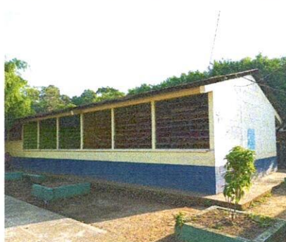
Foto 2: Mantenimiento de balcones (lijado, cepillado y aplicación de 2 manos de pintura anticorrosivo)
