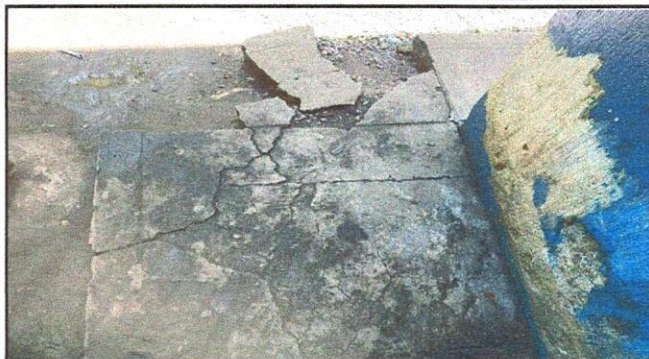
Foto 2: Se realizara la repacion de piso de concreto en pasillo
