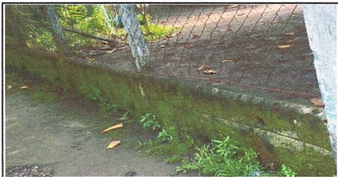
Foto 5: Se realizara la sustitución de maya por continuidad de muro de block
