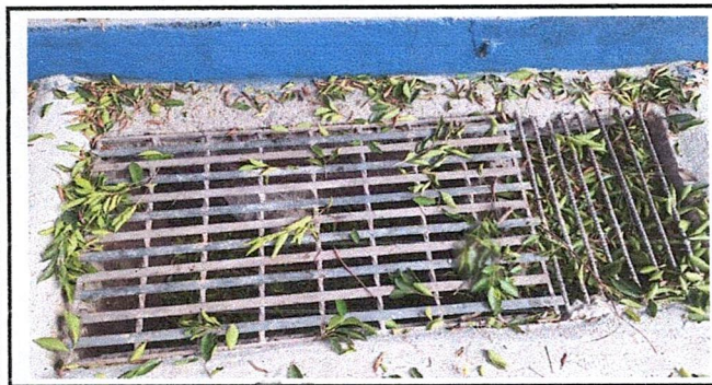
SUSTITUCIÓN DE DRENAJE PLUVIAL
