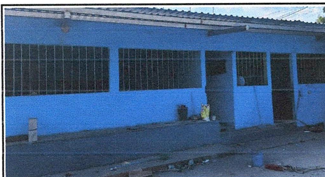
PINTURA EN MUROS INT/EXT
