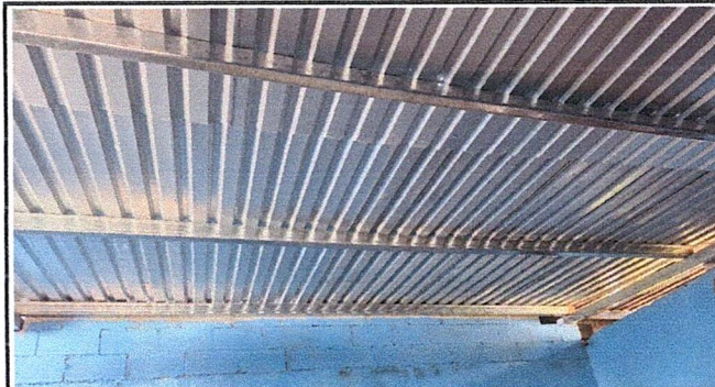
SUSTITUCION DE CUBIERTA DE LAMINA POR LAMINA TROQUELADA
