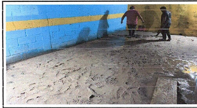
SUSTITUCION DE PISO + BASE DE CONCRETO + SELECTO + REPARACION DRENAJE PLUVIAL
