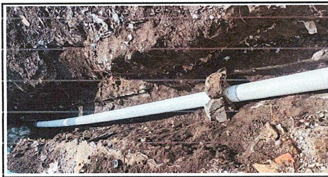
SUSTITUCION DE DRENAJE PLUVIAL
