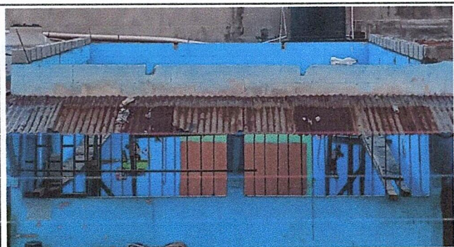
SUSTITUCION DE CUBIERTA DE METAL
