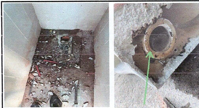
MANTENIMIENTO A SANITARIO + TUBERIA + BASE DE CONCRETO
