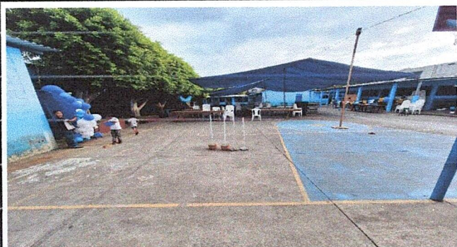
PINTURA EN MUROS INT/EXT
