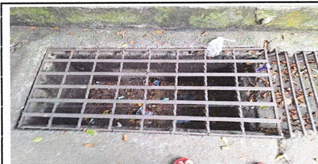
SUSTITUCION DE DRENAJE PLUVIAL
