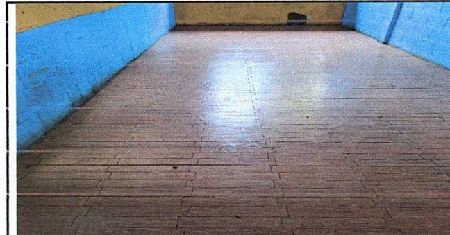
SUSTITUCION DE PISO + BASE DE CONCRETO + SELECTO + REPARACION DRENAJE PLUVIAL
