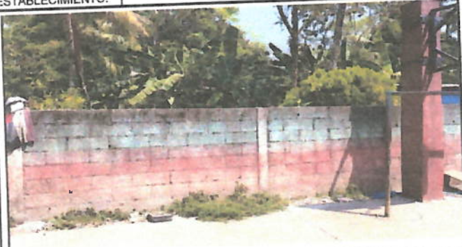
Foto 1: levantado de block 1.40 mts de altura incluye columnas
