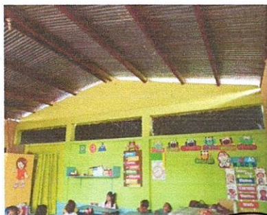
Foto 5: Hechura e instalación de ventanas para eliminar el nylon negro que genera calor en el ambiente. También se aplicará pintura en balcones existentes.
