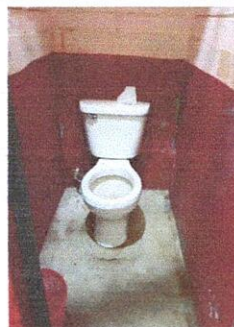
Foto 6: Sustitución de accesorios de 7 sanitarios lavables (flote, sapito, válvula de llenado y tapadera).
