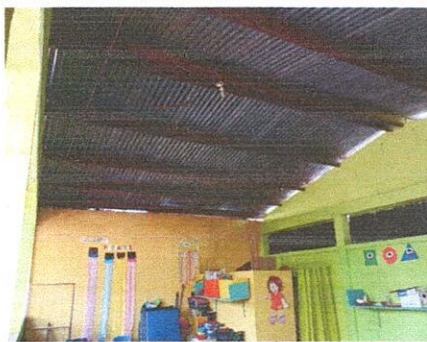
Foto 4: Sustitución de estructura de sujeción metálico y cubierta tipo zinc
