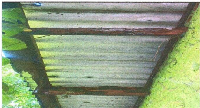
Foto 1: Sustrucción de estructura de soporte de madera existente por estructura de soporte de metal
