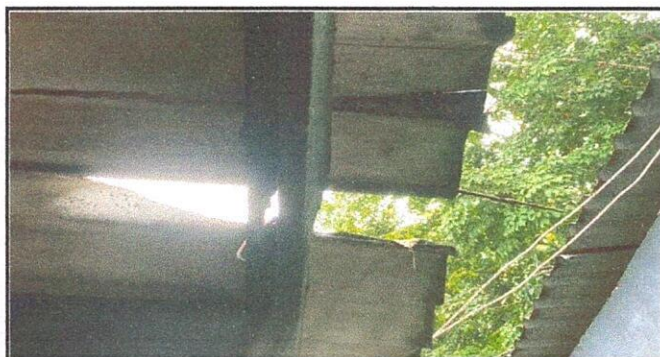
Foto 3: Sustrucción de estructura de soporte de madera existente por estructura de soporte de metal
