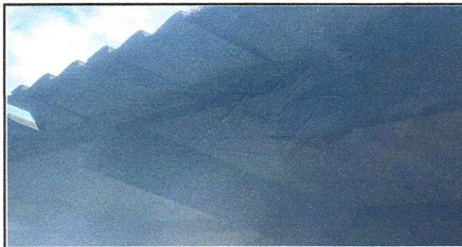
Foto 6: Sustrucción de lámina de duralita por lámina troquelada aluzinc calibre 26
