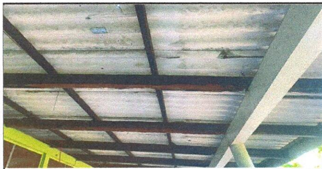
Foto 5: Sustrucción de estructura de soporte de madera existente por estructura de soporte de metal
