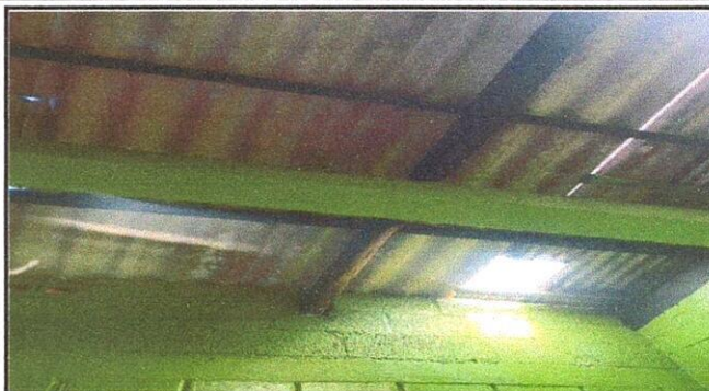
Foto 2: Sustrucción de lámina de duralita por lámina troquelada aluzinc calibre 26
