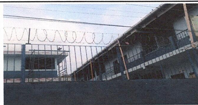
Foto 5: Sustitución de alambre de seguridad (RAZOR)
