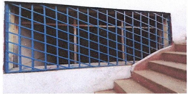
Foto 2: (suministro de ventana pvc.).
