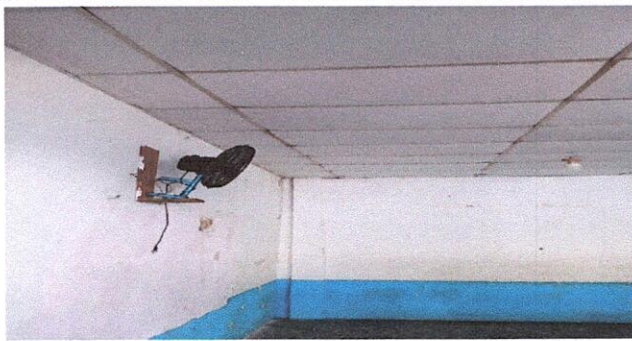
Foto 3 : Sustitución de cielo falso, sustitución de plafoneras y focos led.
