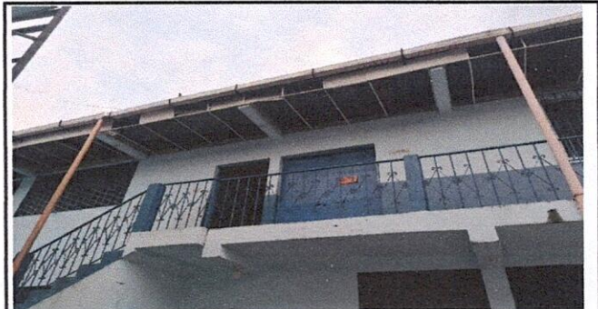
Foto 6. Sustitución de Canal de metal + tubería pvc. Para bajadas de aguas pluviales.
