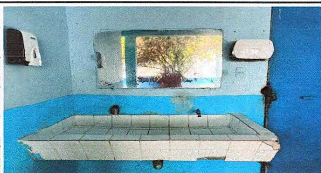
Foto 10: Sustitución de azulejo y chorros en lavamanos
