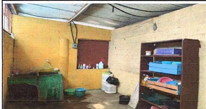
Foto 1: Reparación de áreas de cocina
