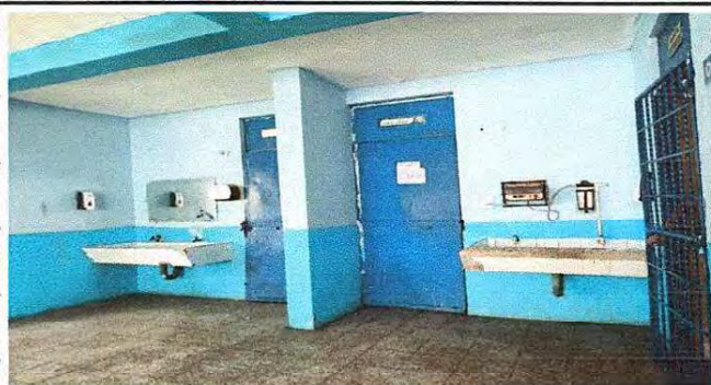
Foto 8: Sustitución de puertas de ingreso a servicios sanitarios, sustitución de azulejo y chorros en lavamanos
