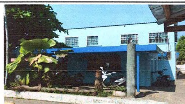
Foto 4: Aplicación de pintura en muros de cocina, suministro de balcón en ventana de ventanas
