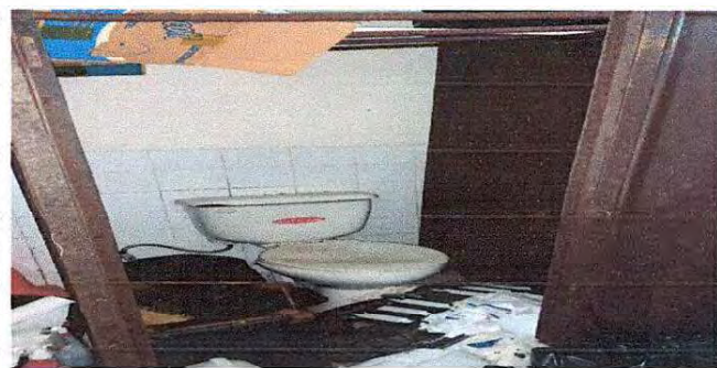
Foto 7: sustitución de azulejo en interior de servicios sanitarios, sustitución de divisiones de metal por divisiones de block tabique, sustitución de inodoros incluye accesorios
