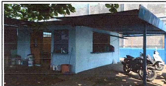
Foto 3: Sustitución de cubierta de lámina, sustitución de puerta, sellado de ventana (a la par de la puerta de ingreso), aplicación de pintura en muros
