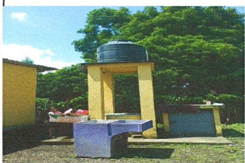
Foto 1: Sustrucción de depósito de agua 2500 lts
