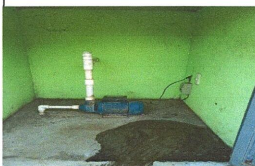
Foto 2: Sustrucción de bomba de agua
