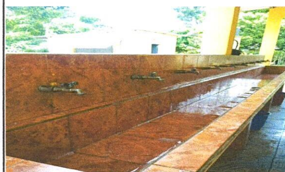
Foto 3: Sustrucción de llave de chorro (incluye: chorros Ø 1/2", permatex, teflón)
