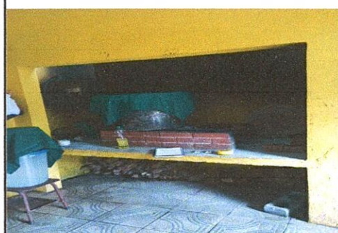
Foto 4: Sustrucción de estufa rural (completa) incluye; levantado de block, ladrillo tayuyo, cemento, arena y chimenea; dimensiones: 1.20 m largo x 1.00 m de ancho
