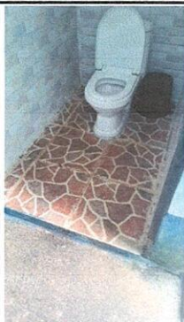
FOTO 1: SUSTITUCION DE INODORO
