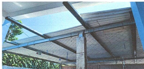
FOTO 2: INSTALACION DE LAMINA
