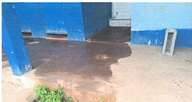
FOTO 3: SUMINISTRO DE REPOSADERA
