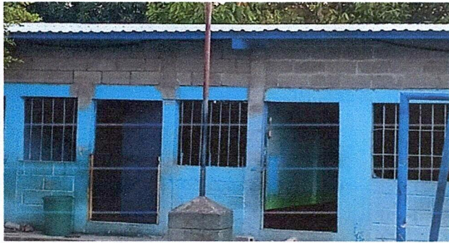
VANO DE VENTANAS Y COLOCACIÓN
