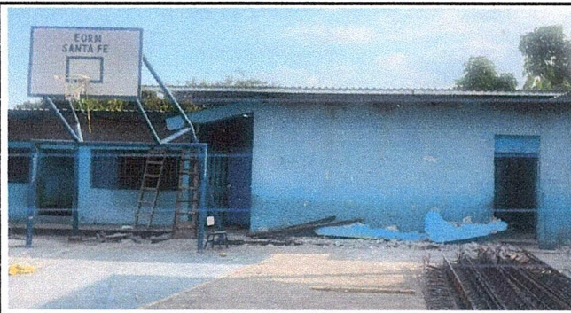
SUSTITUCION DE CUBIERTA DE LAMINA POR LAMINA TROQUELADA CALIBRE
