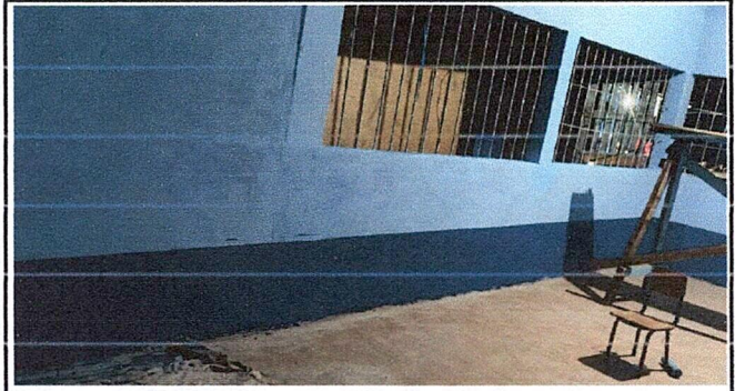
APLICACIÓN DE PINTURA EN MUROS INT/EXT
