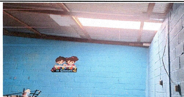
CAMBIO DE LÁMINA POR LÁMINA PLASTICA BLANCA PARA ILUMINAR 2 AULAS
