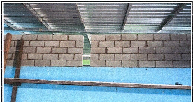
NIVELACION CON LEVANTAMIENTO DE MURO PARA LA PENDIENTE DEL TECHO
