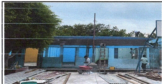
SUSTITUCION DE ESTRUCTURA DE SOPORTE DE TECHO DE MADERA POR ESTRUCTURA DE SOPORTE DE TECHO DE METAL
