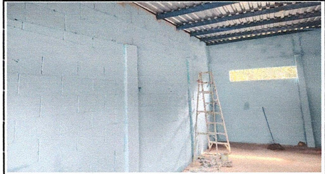
APLICACIÓN DE PINTURA EN MUROS INT/EXT
